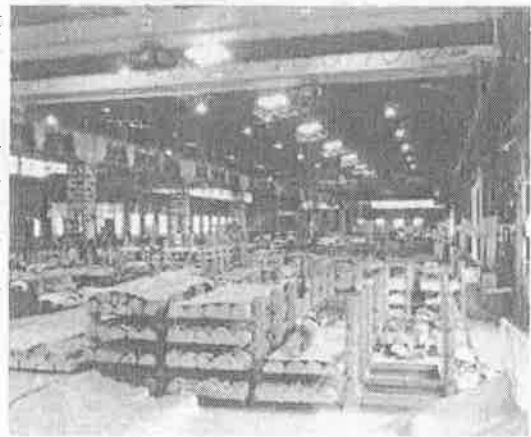
天井クレーンや出入り口を増設した倉庫
